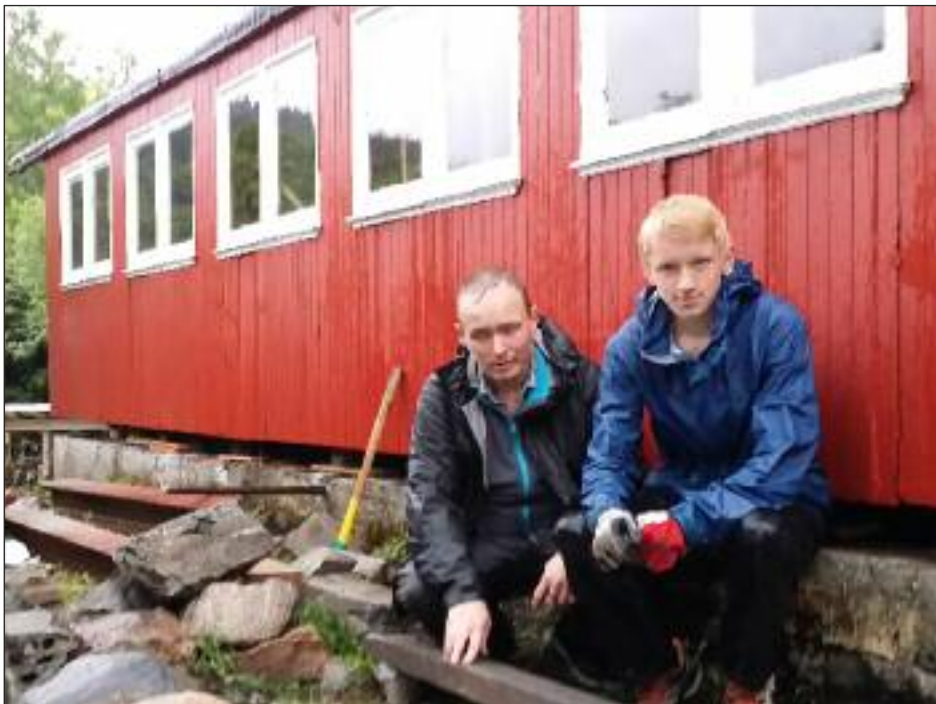
Liftoff! Sakte men sikkert ble vogna løftet opp med donkraft, slik at det ble mulig å tre bjelker på tvers under de lange stålbjelkene. På bildet ser vi Jarl A. og Jørgen Aspaker.
