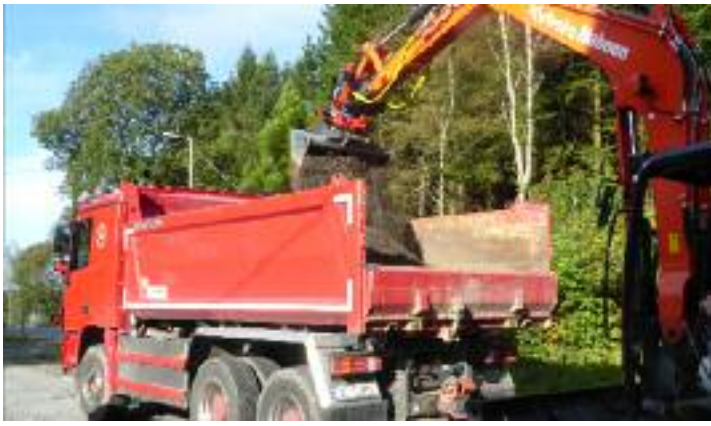
Opplasting for å kjøre bort gammel ballast. Foto Ingvard Aam 5.09.2016
