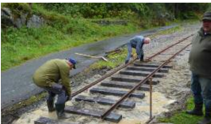
Bjørn og Svein Tore legger ut skinner. Legg merke til vanntilsiget. Foto Ingvard Aam 10.09.2016
