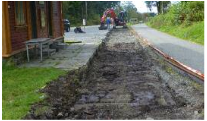
Det meste av trasseen gravd ut. Foto Ingvard Aam 5.09.2016
