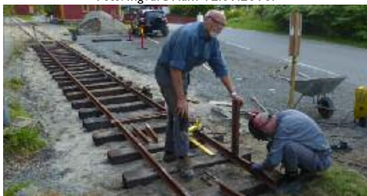
Svein Tore sveiser fast deler til stoppbukk. Foto: Ingvard Aam 13.09.2016.
