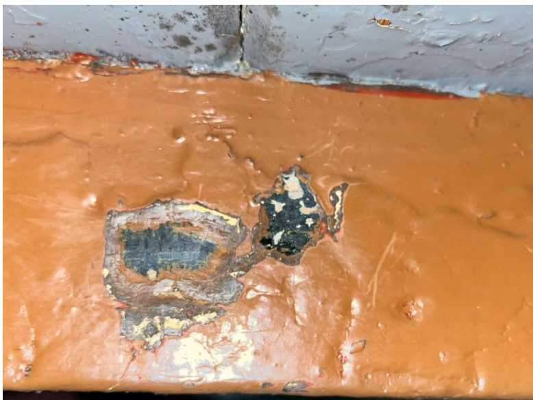
Figur 15. Detaljer i bjelken over enden av plattformen på CDFo I. Laget med svart farge kommer her tydelig frem.
