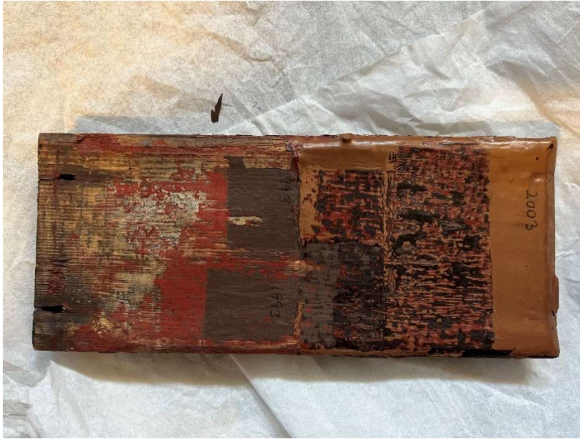
Figur 17. Panelbord som har stått over vindu på sidevegg og vært delvis beskyttet av langsgående bord. Den venstre delen av bordet har ligget bak det andre bordet og har ikke blitt malt av Osbanens Venner.
