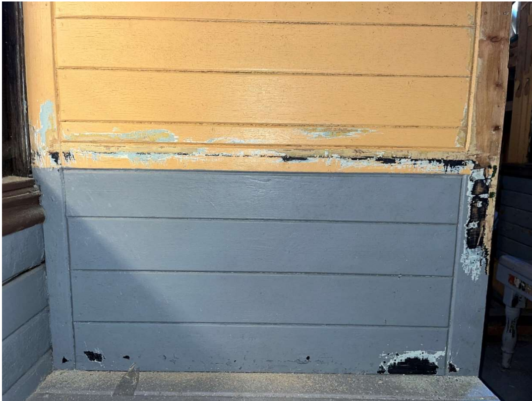
Figur 34. Avdekket blåsvart farge viser omtrent hvor på skilleveggen skillet mellom farge på nedre veggfelt og farge på øvre veggfelt har gått. Skillet er altså gjort omtrent midt på den liggende staven i stenderverket. På endeveggen er derimot øverste bord under staven malt med mørk farge, mens hele staven og panelet over er malt i lys farge. Staven ligger ikke like høyt i endeveggen og skilleveggen. På sideveggene har alle liggende panelbord samt den langsgående profillisten vært malt likt, mens alt over profillisten har hatt annen farge.
