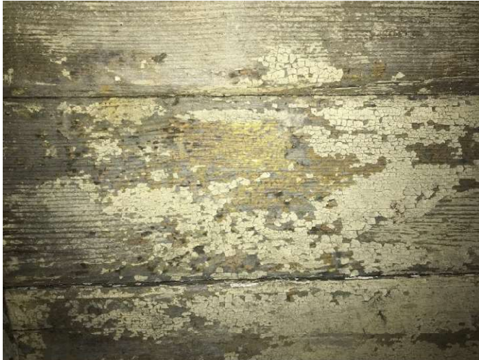
Figur 22. Undersiden av taket over plattformen fra Lyssand-vognen.
