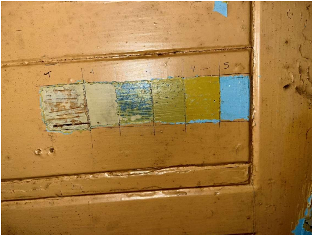
Figur 35. Fargetrapp på øvre del av skilleveggen i postkupeen.
