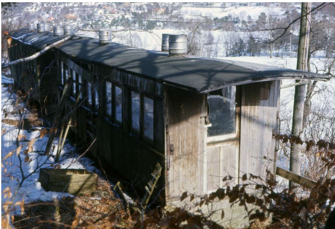
Figur 25. Endeveggen på Oldbury-vognen på Framnes i påsken 1970. Rester av brun maling sees på vegg. Oppe til høyre sees et felt med rødbrun maling der hvor skiltet med «3» har hengt. Foto: Ulf Berntsen.
