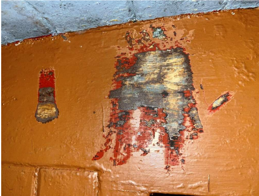
Figur 12. Det faste trestykket under taket, over skyvedøren i CDFo I sin endevegg. Flere flater ble undersøkt uten at andre eldre farger enn grått ble avdekket.
