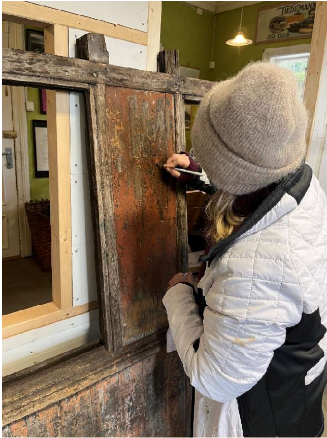
Figur 1. Malermester Janne Nesttun i arbeid med å undersøke utvendig sidevegg fra Lyssand-vognen.
