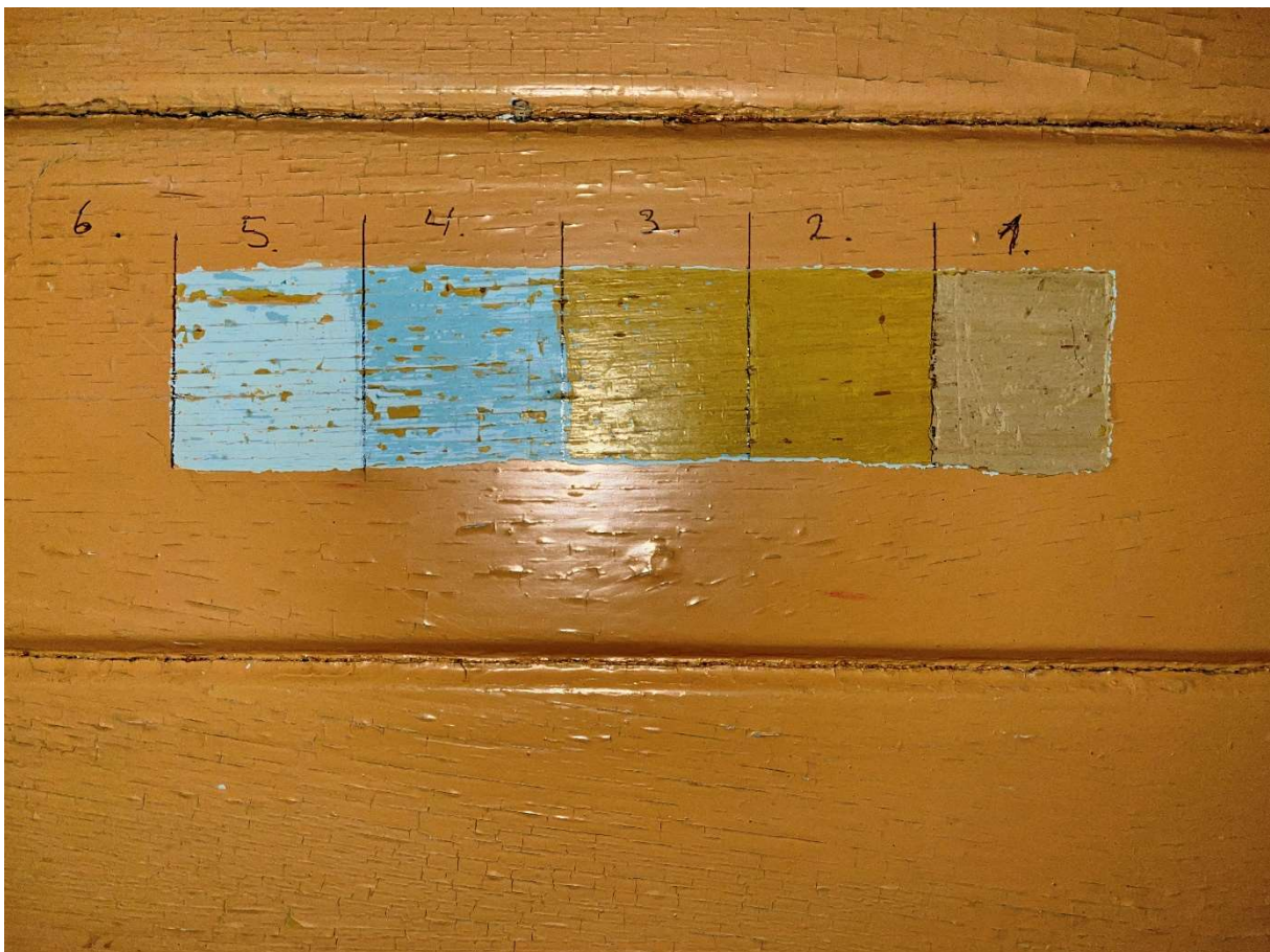
Figur 31. Fargertrapp på øvre del av skilleveggen i passasjeravdelingen i CDFo I. Flere andre steder på veggen er det senere avdekket et lag med lasur mellom lag 1 og 2.
