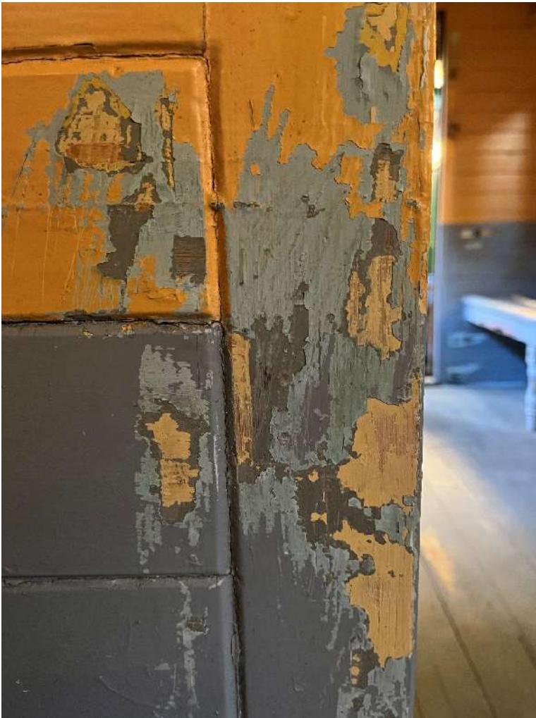
Figur 36. Undersøkte felt på skilleveggen i CDFo I, sett fra postkuppeens side.
