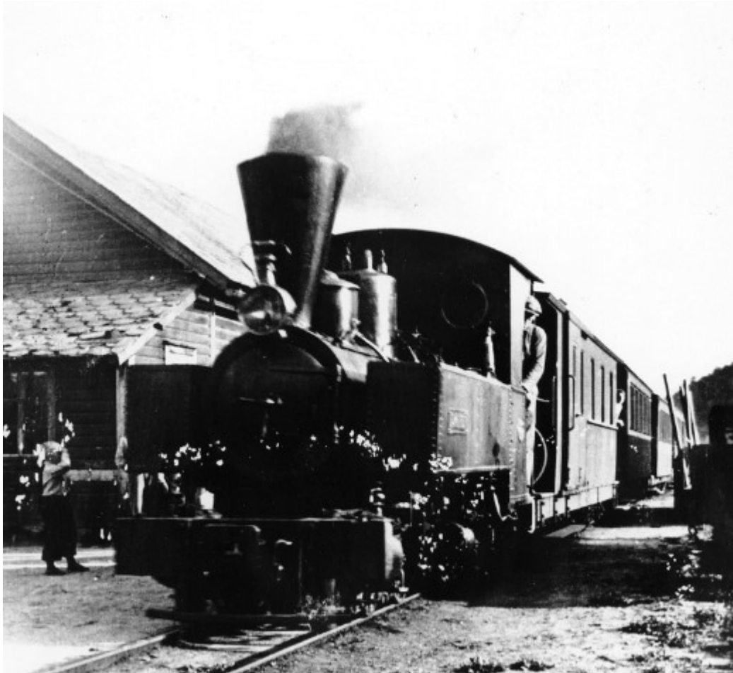
Figur 56. Tog på Sjøfteland stasjon i Osbanens siste tid. En av Oldburys kombinertvogner går rett bak lokomotivet. Legg merke til det ekstra håndtaket ved skyvedøren. Dette bildet viser også at stigtrinet var blitt forlenget til å gå under både plattform og åpning til konduktørrommet. Foto: NJK Bergens samling.
