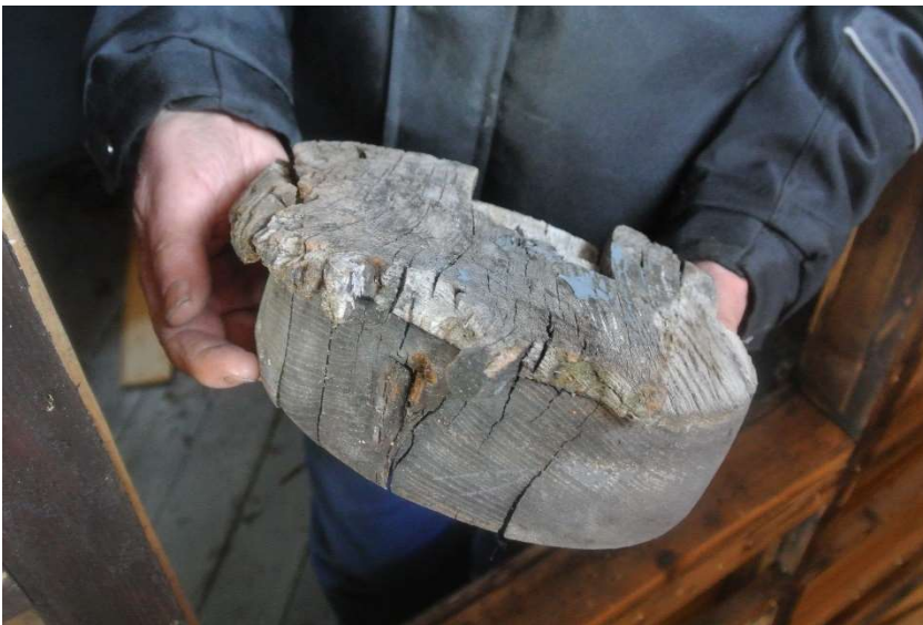
Figur 47. Den samme treklossen løftet opp og ut av taket.
