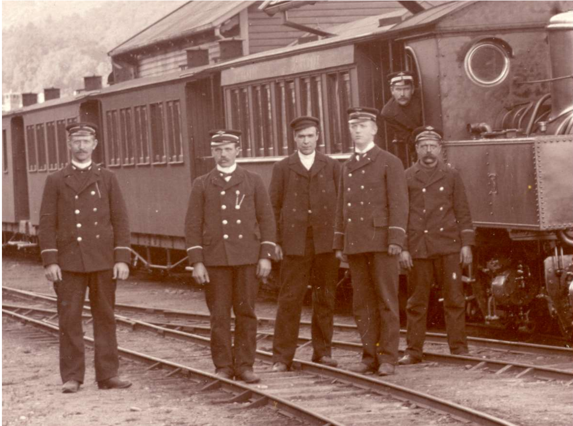
Figur 60. Utsnitt av foto tatt på Os stasjon i 1899. Nærmest lokomotivet står en vogn litra Co eller BCo bygget av Oldbury. Teksten som forteller klasse, er synlig på bordet som ligger over vinduene. Foto: Gerhard Berg. Osbanens Venners fotosamling.
