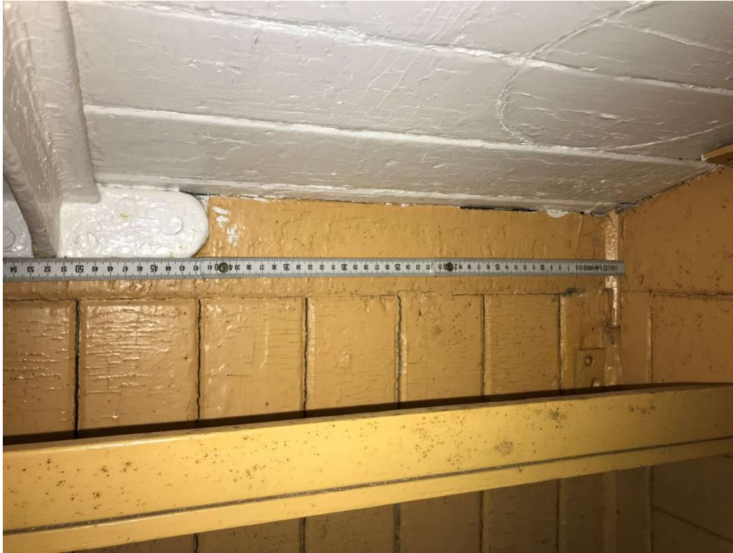
Figur 54. Taket i postkupeen, på motsatt side av der hvor posthyllen står. Oppe til høyre sees gammel åpning for ovnsrør. Foto: Per Ivar Tautra.
