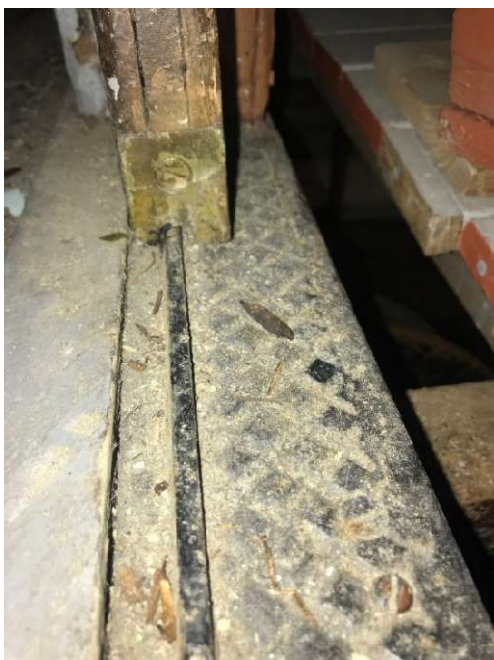
Figur 29. Stålplate med styreskinne på bunnsvillen under skyvedør.
