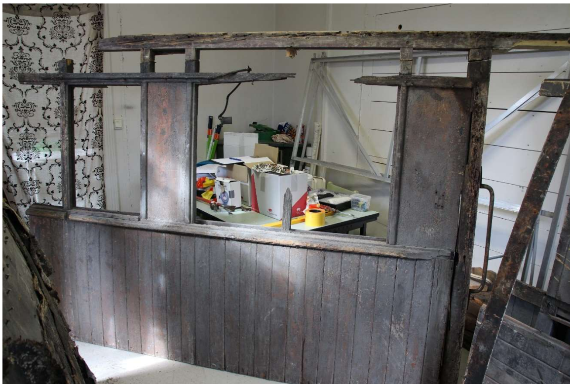
Figur 57. Del av sidevegg fra Lyssand-vognen. Vi ser utsiden. Legg merke til de flate treplatene som sitter mellom vindusparene og mellom vinduspar og endestokk. Det er vognens endestokk vi ser til høyre. Håndtaket sitter fremdeles på opprinnelig plass. Foto: Per Ivar Tautra.
