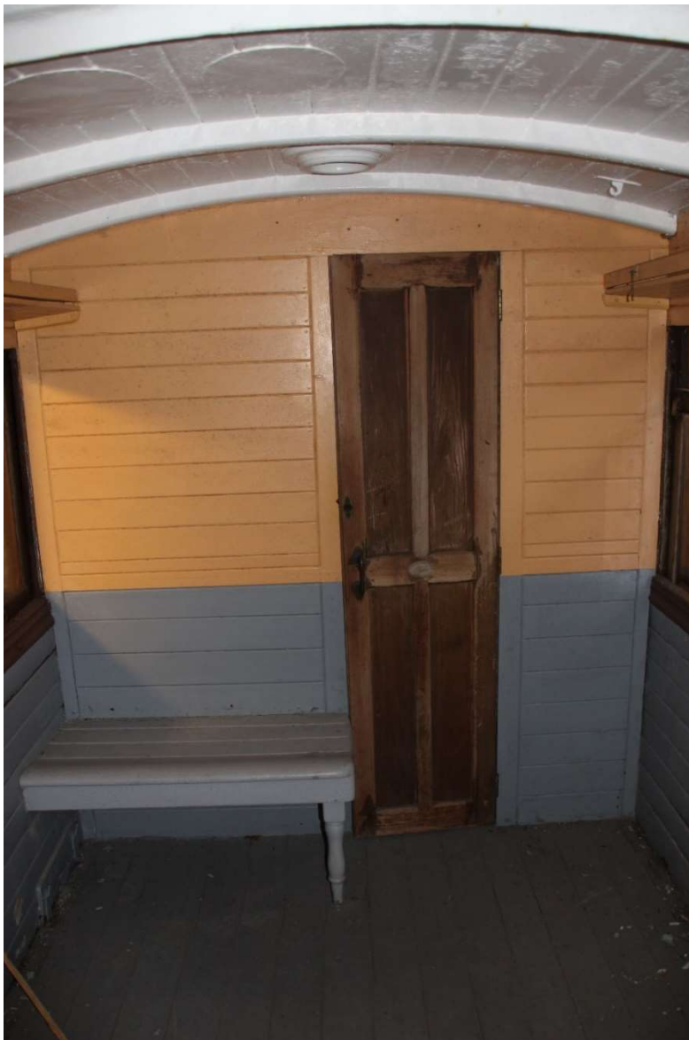
Figur 32. Til venstre: Eksisterende skillevegg sett fra passasjeravdelingen mot postkupeen. Foto: Per Ivar Tautra.
