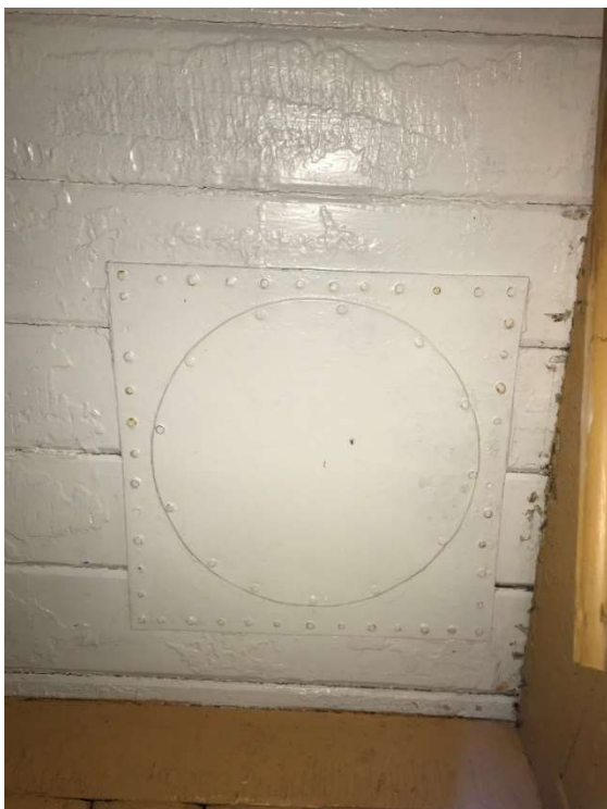
Figur 53. Åpningen i taket for ovnsrør i hjørnet av passasjeravdelingen, sett fra undersiden.
