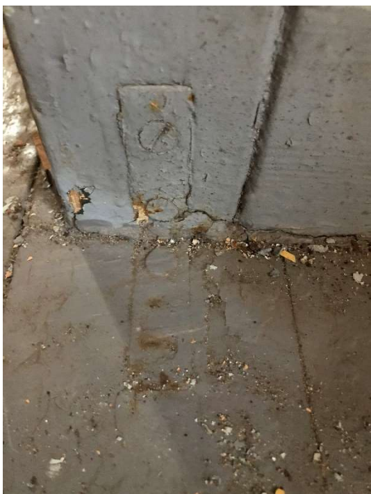
Figur 34. Vinkeljern mot skilleveggen i postkupeen. Foto: Per Ivar Tautra.
