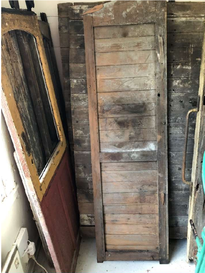
Figur 13. Bakside av innvendig panel i endevegg fra Lyssand-vognen. Foto: Helge Berntsen.
