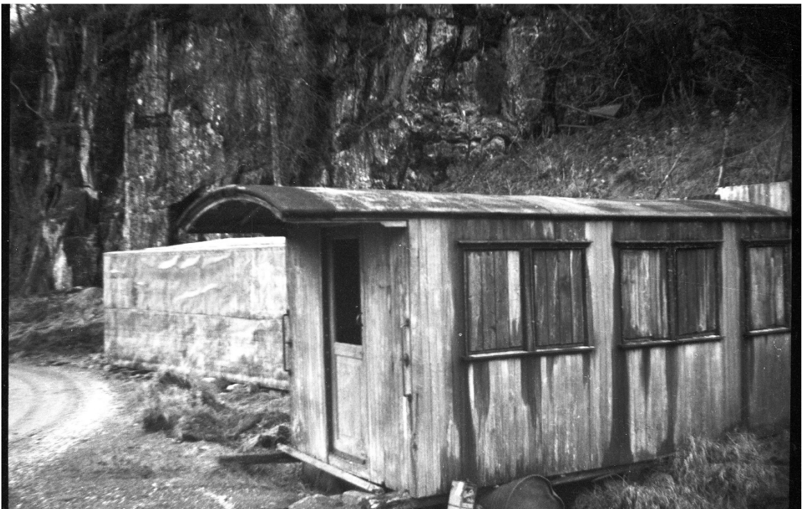
Halv Skabo-vognkasse som anleggsbrakke ved Fanafjellsvegen på 1950- eller 60-tallet. Foto: Yngve Willgohs
